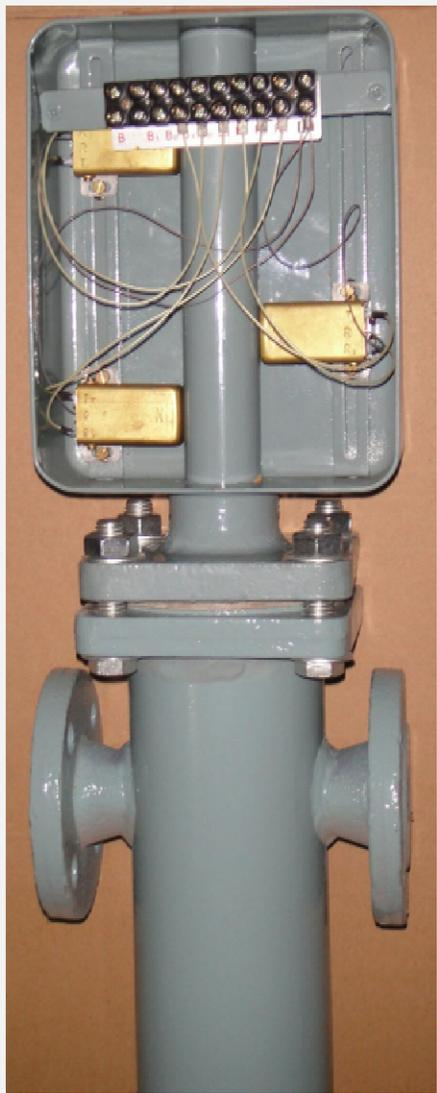
图4-35 UQK-32型浮球式锅炉水位控制器结构图
